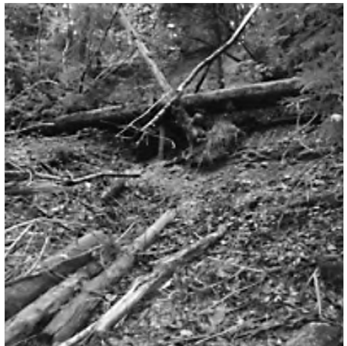
Druckleitung des Wasserrechts Nr. 79/Bild: Schulthess & Dolder AG
